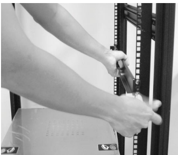
步骤 1. 将滑轨锁在机架上
